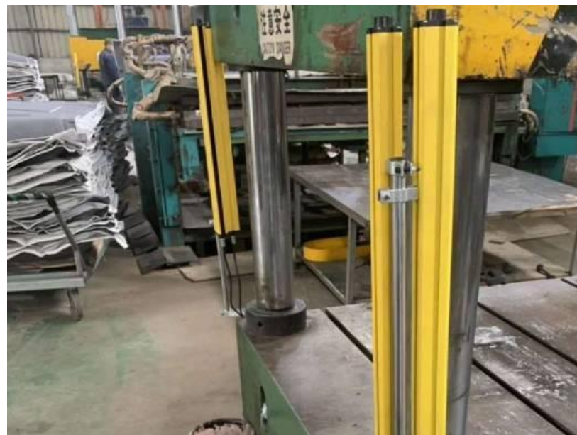
冲床设备安装光栅开展安全技术改造
