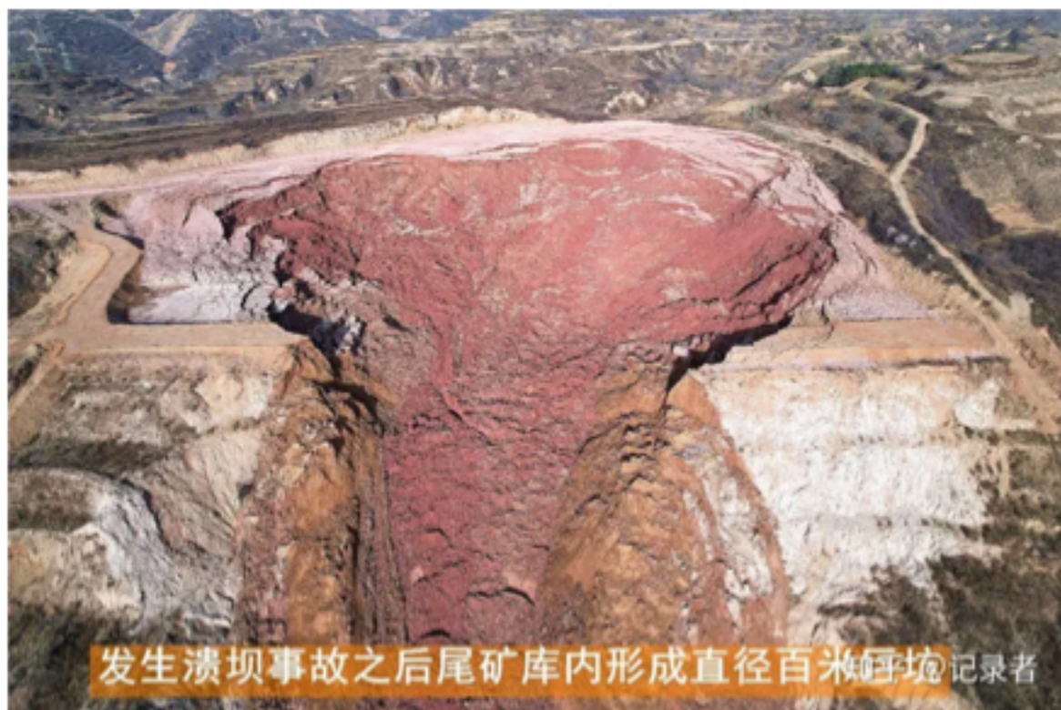
山西交口一尾矿库发生溃坝事故
